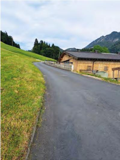
Es kam das sogenannte Fräsrecycling-Verfahren zur Anwendung. Bei der zeit- und kostensparenden Ausführungsvariante wird in einem Arbeitsgang der bestehende Asphalt abgetragen und ein homogener Unterbau geschaffen.
