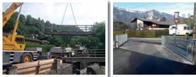
Die Klauslerbrücke, eine Stahlträgerbrücke mit Holzbohlenbelag, wurde im Sommer komplett durch eine Stahlbetonbrücke ersetzt.
