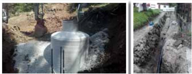
Links: Ableitung der oberen Silberbergquelle, rechts: Die neue Behälterableitung wurde ans Netz angeschlossen.
