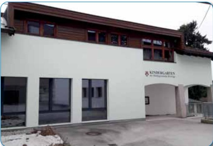
**Sanierung Fassade Kindergarten.** Fassadenputz und Holzoberflächen wurden saniert und neu beschichtet.
